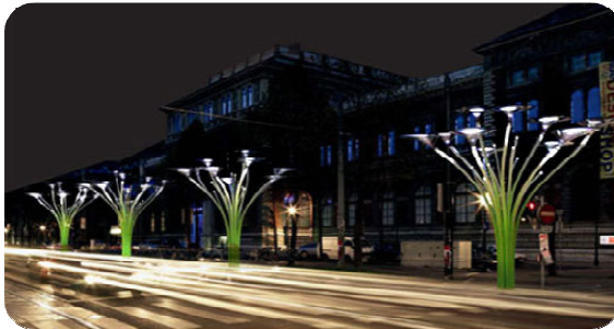
Lampadaire design à LED, alimenté par des panneaux photovoltaïques
